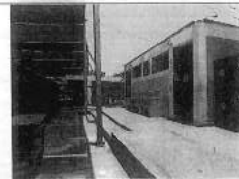
ESTRUCTURA METALICA DE SOPORTE DE MALLA RACHEL CON INCLINACIONES Y SEPARACION DE PLANCHA DE ACERA CON RELACION AL PISO.
