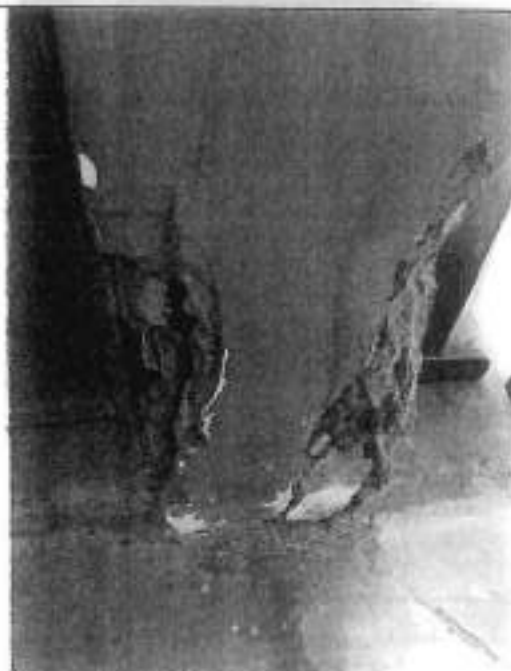
Se observa degradación del concreto y mal estado del acero de refuerzo de columnas del pabellón D y E
